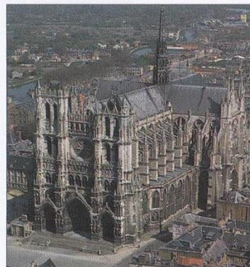
Una doppia fila di 22 eleganti archi rampanti sostiene l'imponente struttura.
